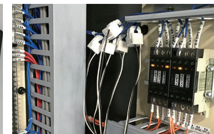
▲稼働中の既存機械設備への取り付け例
